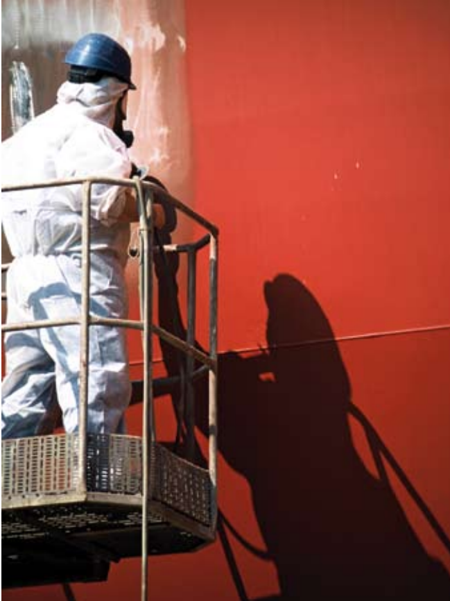
Anbringen von sicherem Korrosionsschutz ist immer noch Handarbeit
