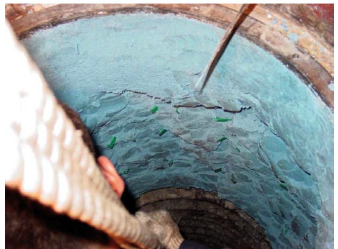
Anbringen einer neuen Kesselausmauerung
