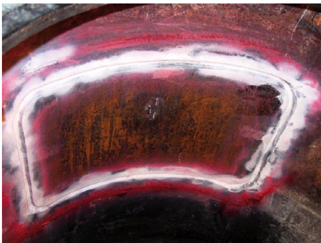
Austauschen defekten Materials (zugelassenes Reparaturverfahren)
