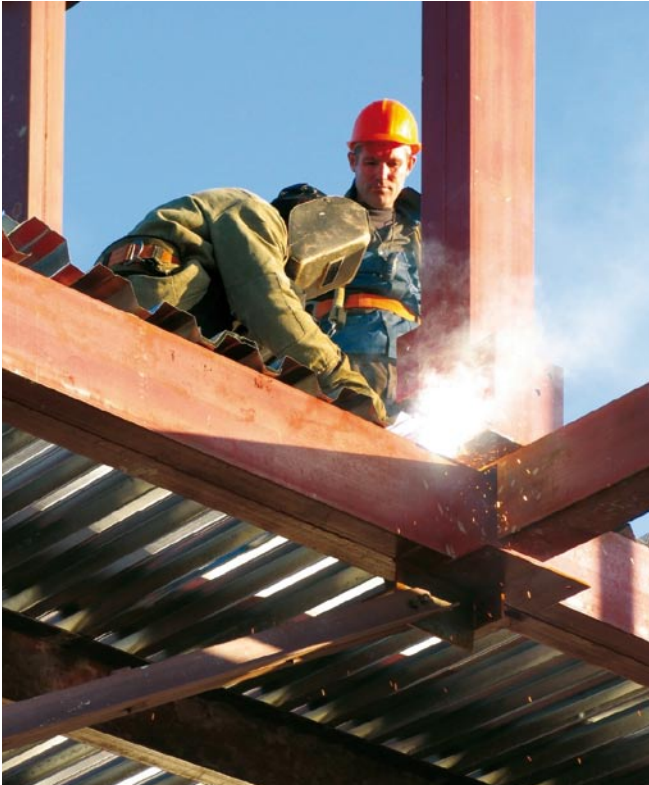
Direkt vor Ort: Schweißerzertifizierungen für Schweißarbeiten im Bauingenieurwesen
