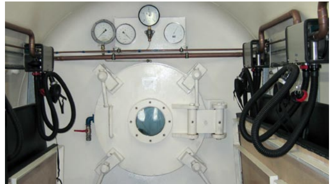
Katzentunnel: der GL hat die Funktionsprüfung nach Installation und vor Inbetriebnahme der Druckluftschleuse durchgeführt, um deren Sicherheit und korrekte Funktion zu überprüfen.
